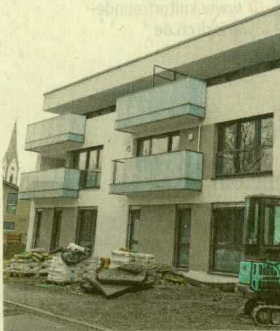
Das Campus-Gebäude nimmt Formen an. Jetzt soll über den Namen entschieden werden. FOTO: TUTSCHNER
